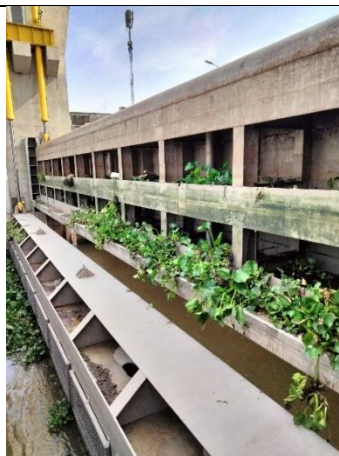
2-3. Cửa van vận hành thẳng đứng bằng hệ thống xi-lanh thủy lực (Công Kênh Nhánh, Rach Giá)
