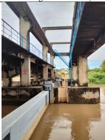
1. Cửa van tự động theo thủy triều (Công Số 3, Hòn Đất)
